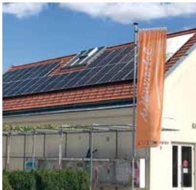
schätzte Jahresertrag der Anlage beträgt 929 kWh/kWp/a, dies bedeutet eine Einsparung von 13.612 kg CO<sub>2</sub>. Errichtet wurde die Anlage von der Firma Elektro Gindl Ges.m.b.H., die mit einem Preis von rd. 26.400,- Euro als Bestbieter aus einem Ausschreibungsverfahren hervorging. Die Finanzierung erfolgt, als Verhandlungsergebnis aus dem Vertrag zum Windpark, durch die ÖKO Energie Wolkersdorf.
