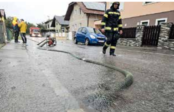
Hochwasser: Auspumpen der Kanalisation am Anger
